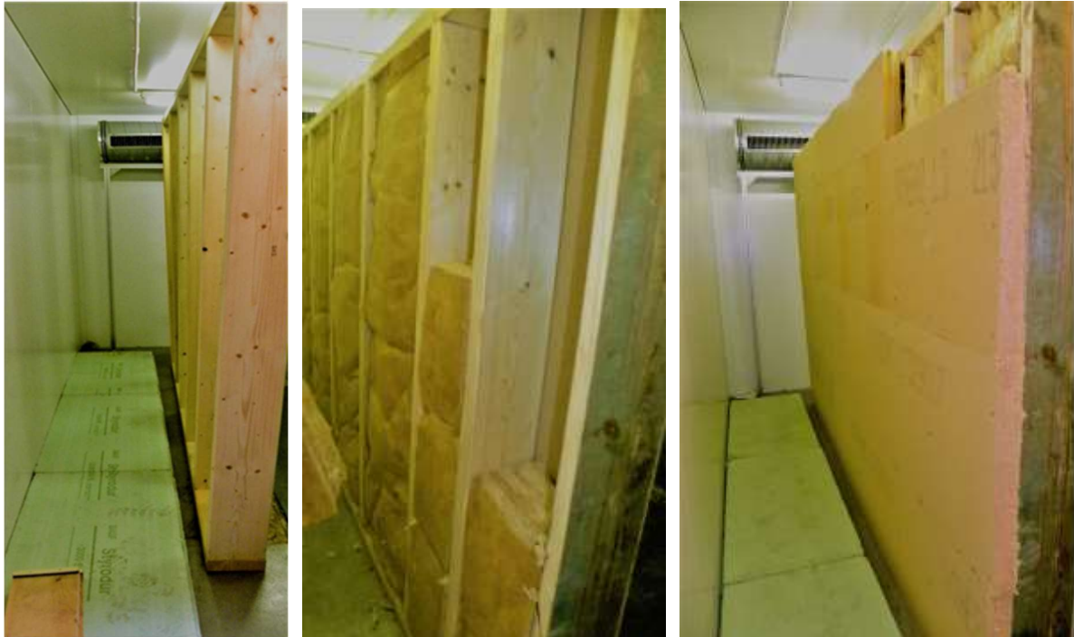
Abbildung 3: Verschiedene Schichten der Probewand.
